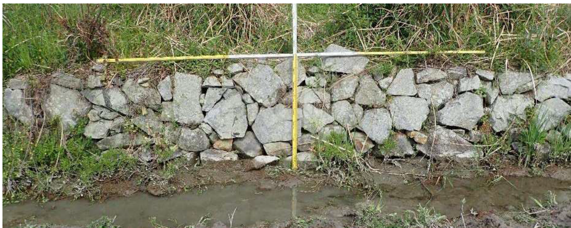
石垣 南東から（高さは、基部から 0.9～1.0m段。北東部は 0.7m程度）
