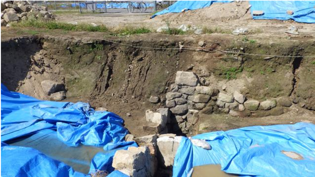
D区石垣（石垣3）
