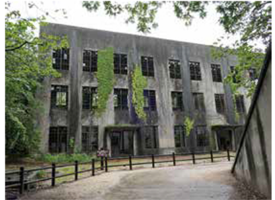
毒ガス工場時代の発電所跡
